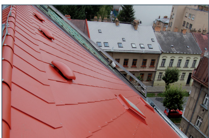
Větrání střešního pláště je realizováno plastovými hlavici.
