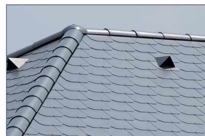
Velikost výstupního otvoru větrací hlavice je 100 cm 2 /lks.
